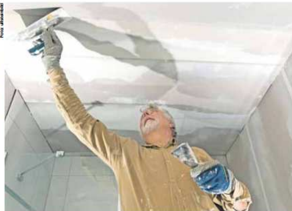
Handymen in deutschen Familien: Handwerker beim Verputzen der Zimmerdecke.
